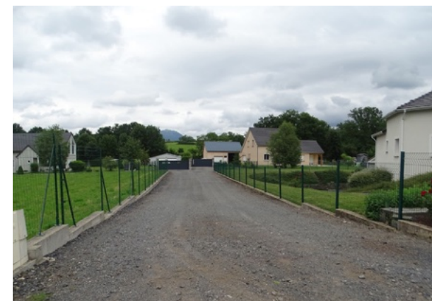
Accès privés en impasse qui dessert 2 maisons au fond
