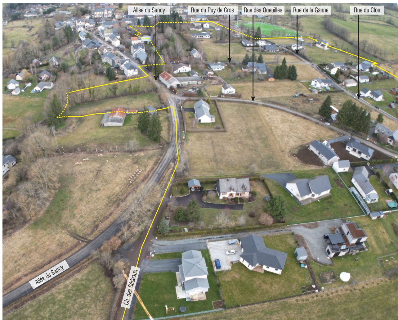
Vue sur le site depuis le sud
