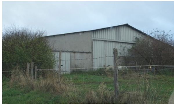
Vue sur la bâtiment agricole depuis la route de Confolens
