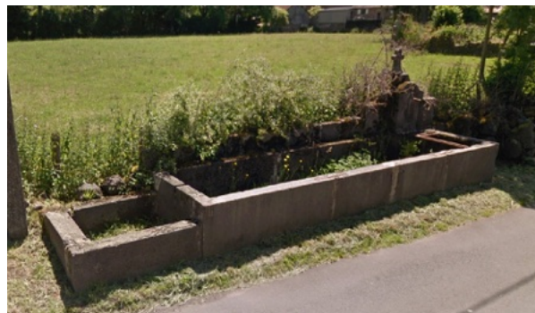
La fontaine-lavoir avec croix située le long de la rue du Puy de Dôme
