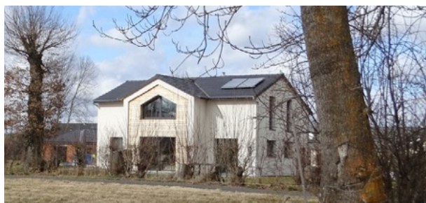
Maison récente rue des Combes : volume massif grâce aux 2 niveaux, maison pente de toiture faible
