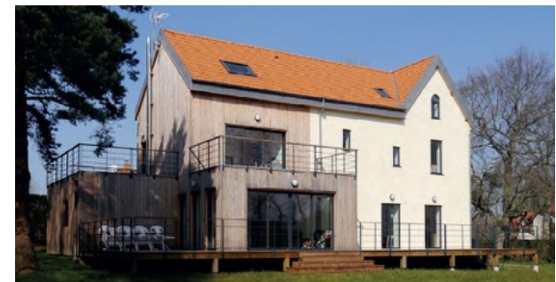
Création de logement par extension de l'existant (source : CAUE 76)
