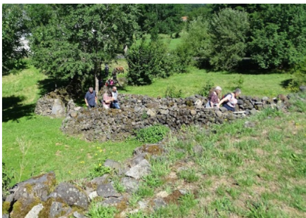
Préservation des murets en pierre sèche : en clôture, bords de chemin...
