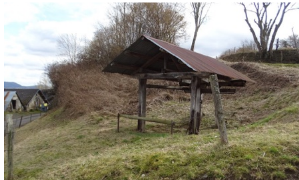
Travail à ferré au Bouchet : une restauration de l'ouvrage, un arbre d'ombrage, un banc et une table, une accessibilité aux personnes à mobilité réduite sont autant de piste pour sa mise en valeur
