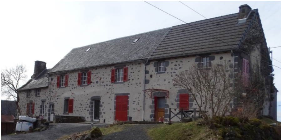
Logis-grange à Bravant rénovée et transformée avec un grand soin jusque dans les détails (encadrements des ouvertures, volets, marquise, éclairage extérieur)
