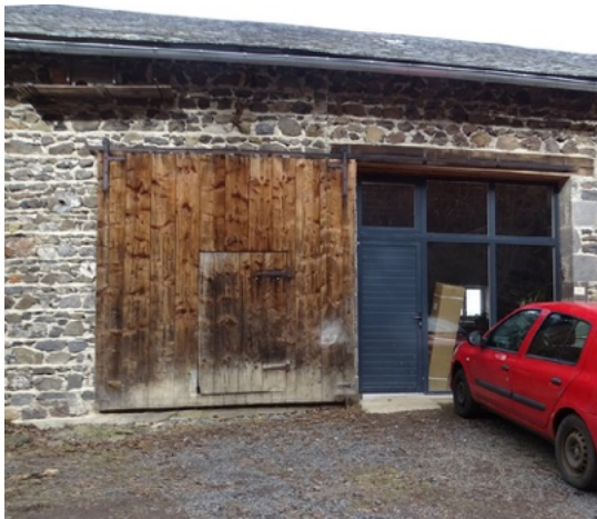
Réhabilitation réussie au Bouchet : proportions des cadres pour la nouvelle entrée, encadrement des vitres de teinte sombre, préservation de l'ancienne porte transformée en volet
