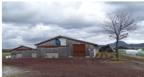
Arbre en accompagnement d'un bâtiment agricole isolé
