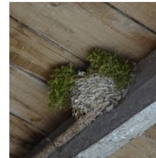
Nid d'hirondelle dans une grange, réinvesti par des passereaux
