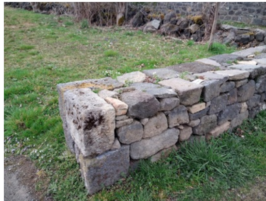
Reconstitution qualitative d'un muret bas : les 4 faces visibles sont régulières, pierres serrées avec peu de cales, pas de coup de sabre, pierres très certainement de réemploi
