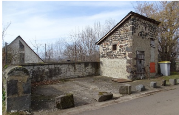
Porcherie à Bravant : les abords méritent une mise en valeur : pavés ou enherbement, arbre d'ombrage, pose d'un banc...)
