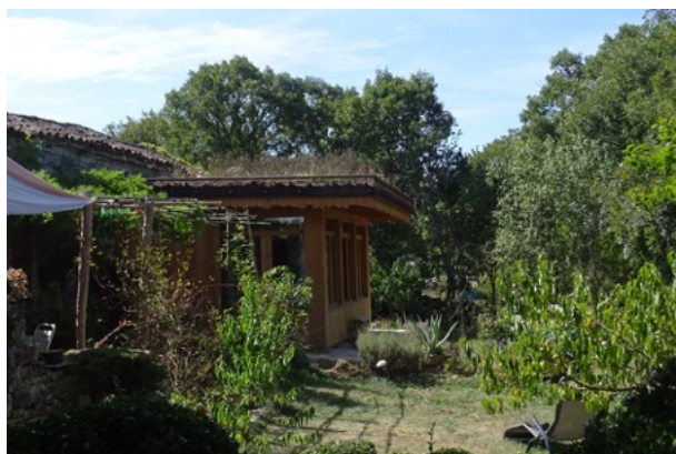
Toiture végétalisée sur 30 cm de hauteur sur une extension contemporaine (Mouillac, 82)
