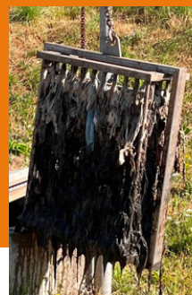
Photo de la grille de la station d'épuration
